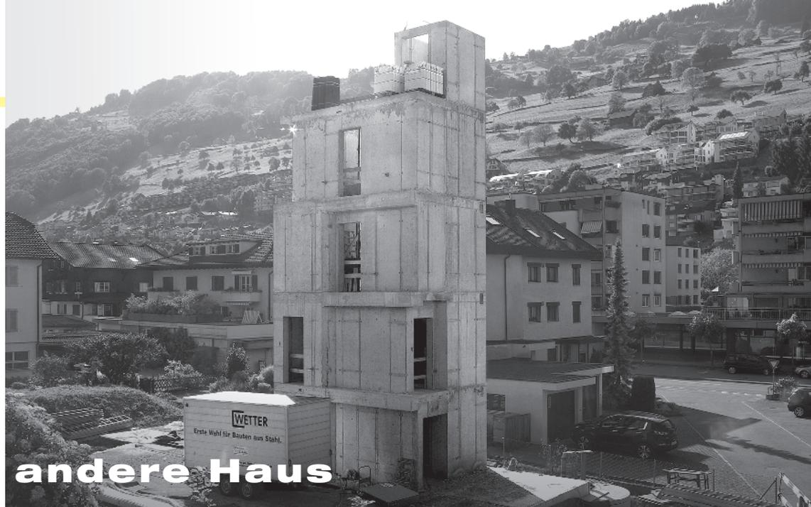
**Aus der Idee, das Untergeschoss wegen des Grundwassers in einer Stahlwanne zu erstellen, entstand schliesslich am Blumenweg ein hindernisfrei zugängliches Wohnhaus in Stahlbauweise mit einer Minergie-Aussenhülle und Naturschiefer-Fassade.**
