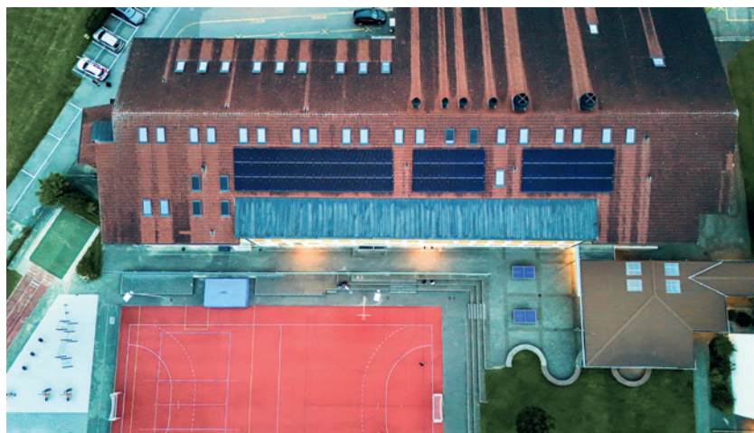
PV-Anlage Schule Ennetbürgen
