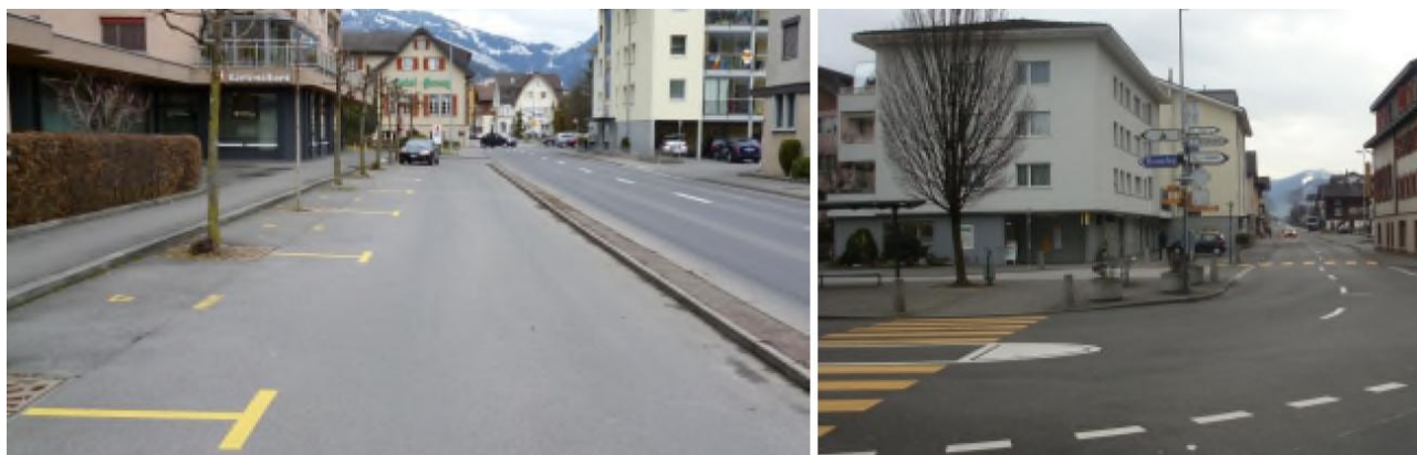
Abbildung 27: Links: Der neue Durchlass verläuft je hälftig unter dem Trottoir und Parkplatz (Blick in Fließrichtung von Bank nach [altem] Hotel Kreuz); Rechts: Der neue Durchlass quert zwischen Bank, [altem] Hotel Kreuz und Post die Stanserstrasse, führt unter Parkplätzen, Trottoir, Busspur, Bushaltestelle und wiederum Stanserstrasse zum Kirchplatz (Blick gegen Fließrichtung von Bushaltestelle Post nach Bank) ( [6]).
