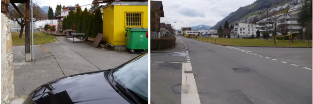
Abbildung 35: Links: Bestehender Hangkanal und bestehender Bitzikanal, welcher mit Betonplatten zugedeckt ist (Blick in Fliessrichtung von Scheune AGRA nach Sonnhaldenstrasse); Rechts: Stationsstrasse mit AGRA im Hintergrund. Einmündung Sonnhaldenstrasse rechts (Blick gegen Fliessrichtung von Verzweigung Stations-, See- und Sonnhaldenstrasse nach AGRA) [6].
