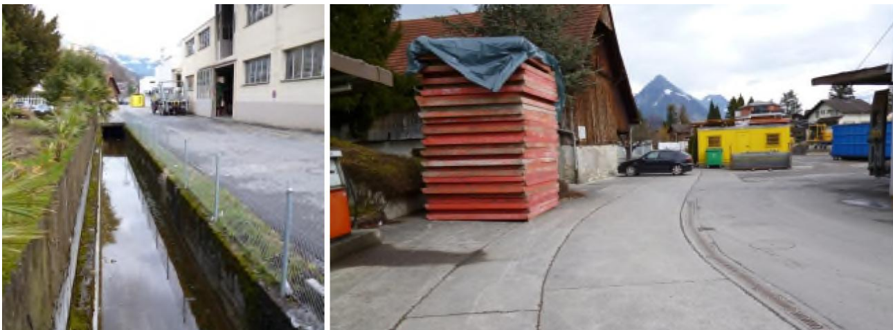
Abbildung 34: Links: Offener, eingezäunter Bitzikanal mit Strasse Vorderboden und AGRA; Rechts: Strasse Vorderboden mit eingedolten Kanälen, Tankstelle AGRA links, Scheune, Gebäude AGRA rechts (Blick in Fließrichtung von AGRA nach Sonnhaldenstrasse) [6].
