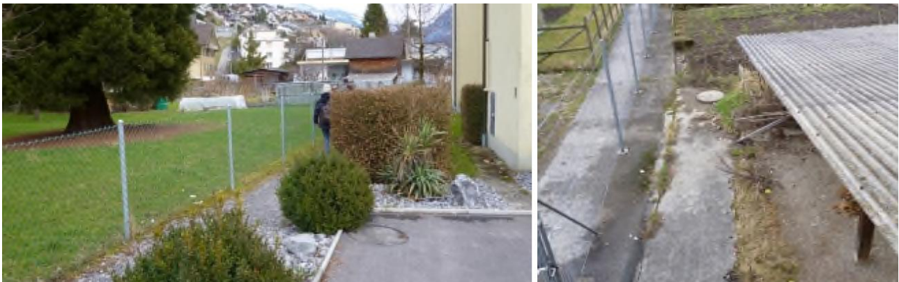
Abbildung 32: Links: Garten auf Parzelle Nr. 8, Fussweg und Parkplatz über den bestehenden Betondurchlässen (Blick in Fliessrichtung von Bürgenstockstrasse zum Volg); Rechts: Garten auf Parzellen Nr. 8, 10, 11 und Fussweg über den bestehenden Betondurchlässen (Blick gegen Fliessrichtung vom Volg zur Bürgenstockstrasse) [6].
