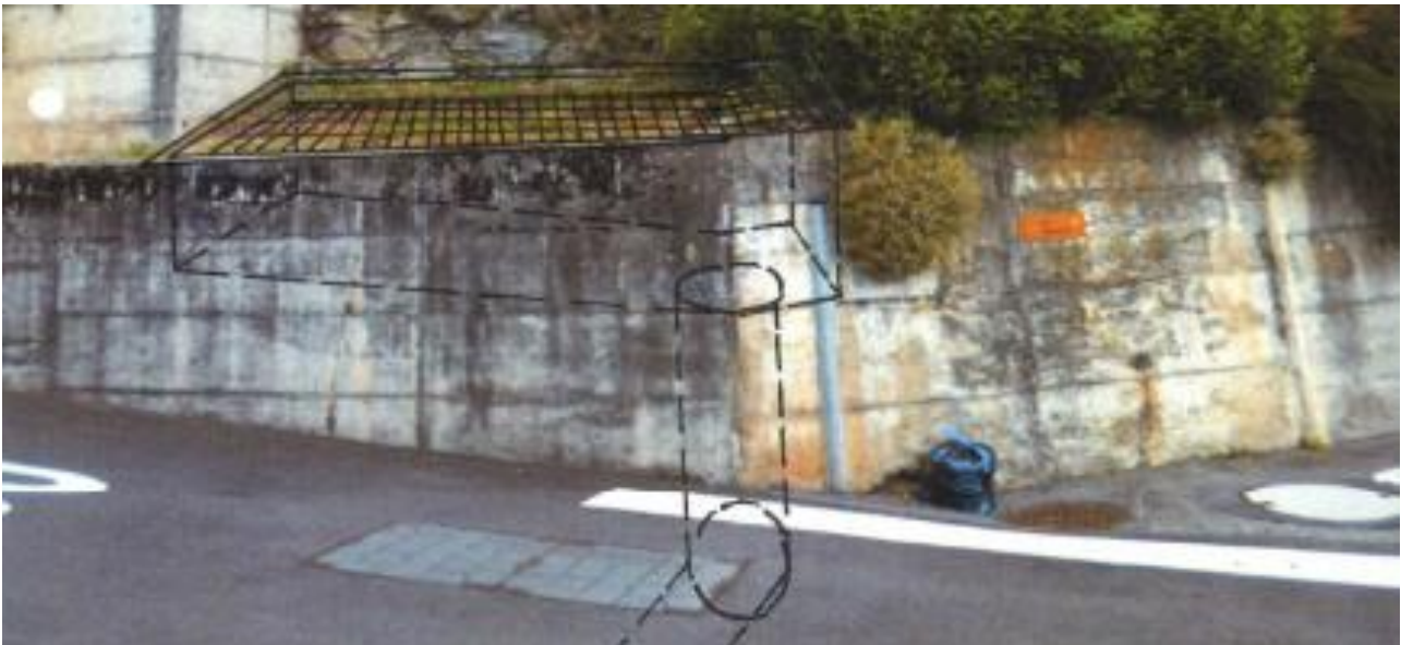
Abbildung 39: Einlaufbauwerk, Tirolerfassung und Rohrleitung [6].
