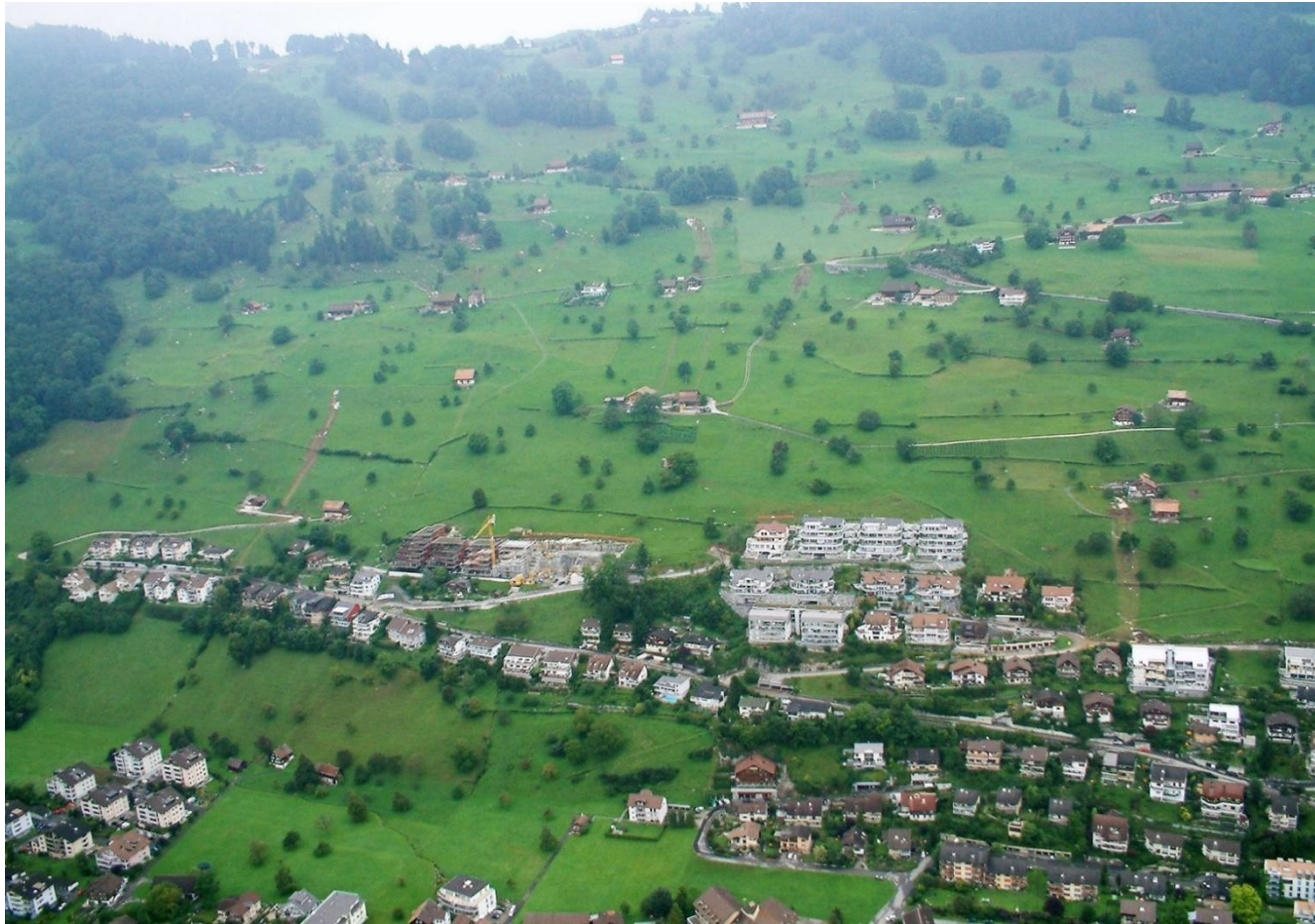
Hochwasser 2005 – Hangmuren, Bereich oberhalb Hofurlistrasse
