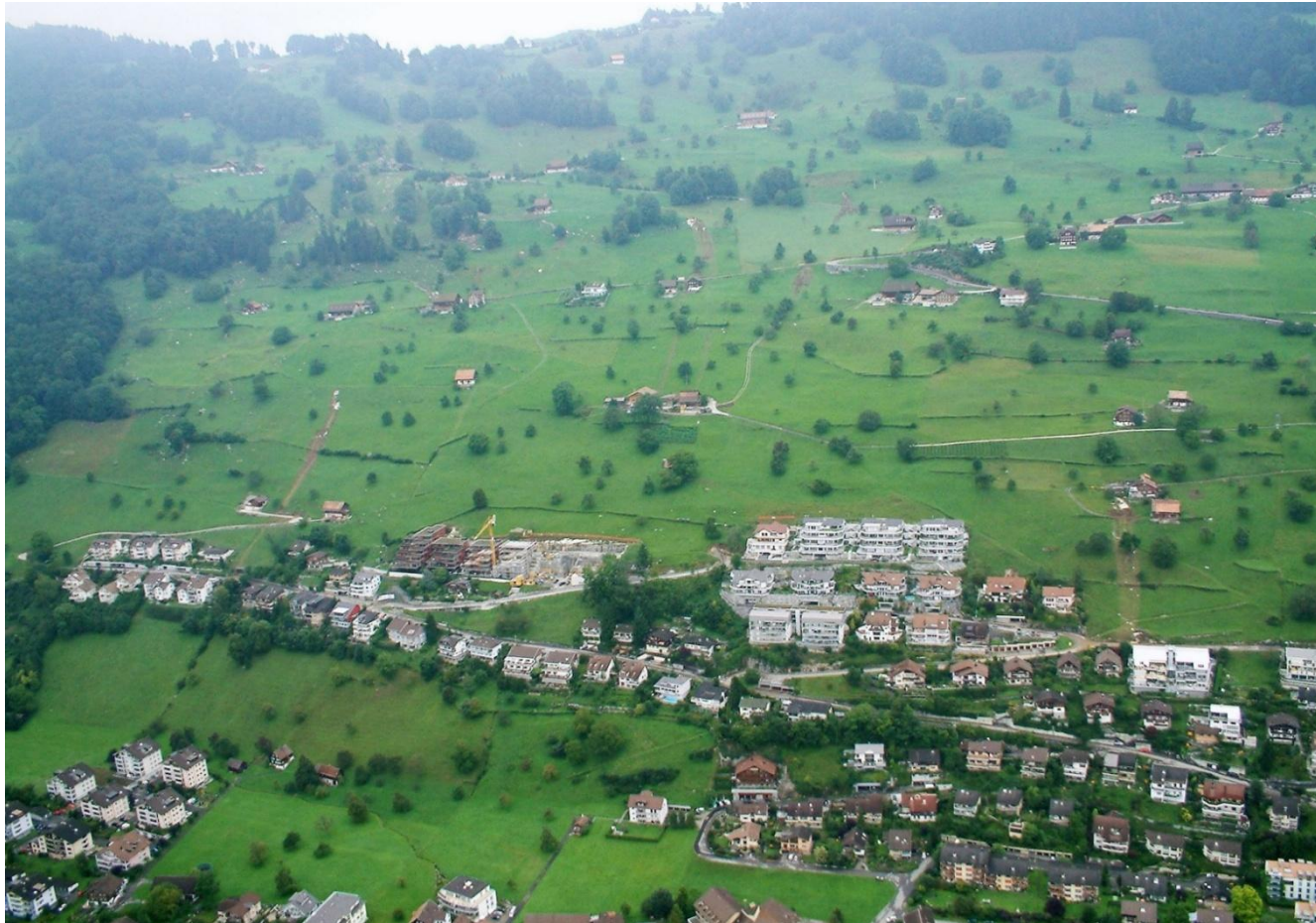
Hochwasser 2005 – Hangmuren, Bereich oberhalb Hofurlistrasse
