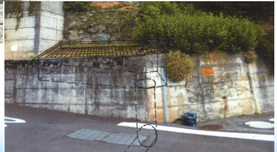
Einlaufbauwerk und Rohrleitung
