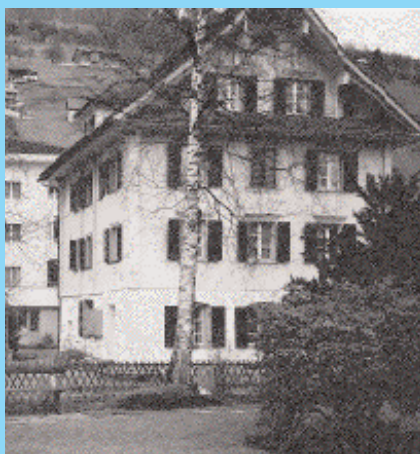
Die extrem engen Raumverhältnisse im Treppenhaus waren der Auslöser für den Anbau auf der Westseite des alten Pfarrhauses.
