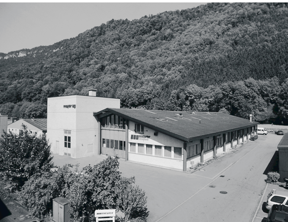
Das Fabrikationsgebäude der Firma Meyer AG im Industriequartier Herdern.
